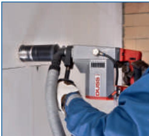
Dosensenken trocken in Kalksandstein mit Absaugung
